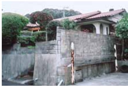
屋根 建物正面
